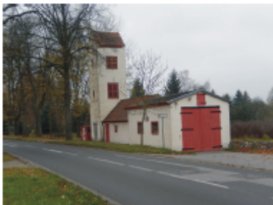
Beispiel: Feuerwehrhaus Wahrsov
